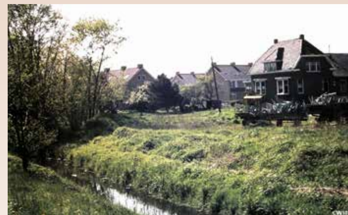
"Buitenlust" vlak voor de sloop in 1975 met daarachter de huizen van de Brembuurt
