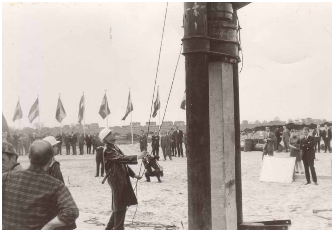
April 1968, burgemeester Thomassen slaat de eerste paal voor de torenflat aan de Söderblomplaats
